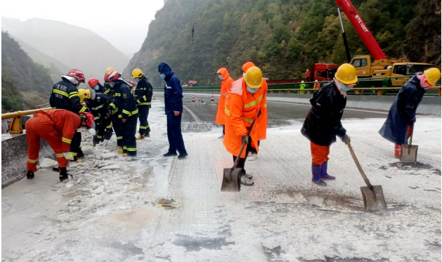
10月5日8时38分，固原市消防救援支队指挥中心接到报警，称青兰高速1583公里处一辆危化品运输车侧翻，车载的碳酸二甲酯泄漏。泾源县政府立即启动化学品事故应急处置应急预案，成立由消防、应急、交警、环保等部门和危化品专家组成的事故处置领导小组，调集大型吊装车辆，采取警戒疏散、水枪稀释、排除险情等措施。经过约40分钟紧急救援，所有碳酸二甲酯被成功转运。 本报记者 苏克龙 通讯员 胡雪垠 摄
