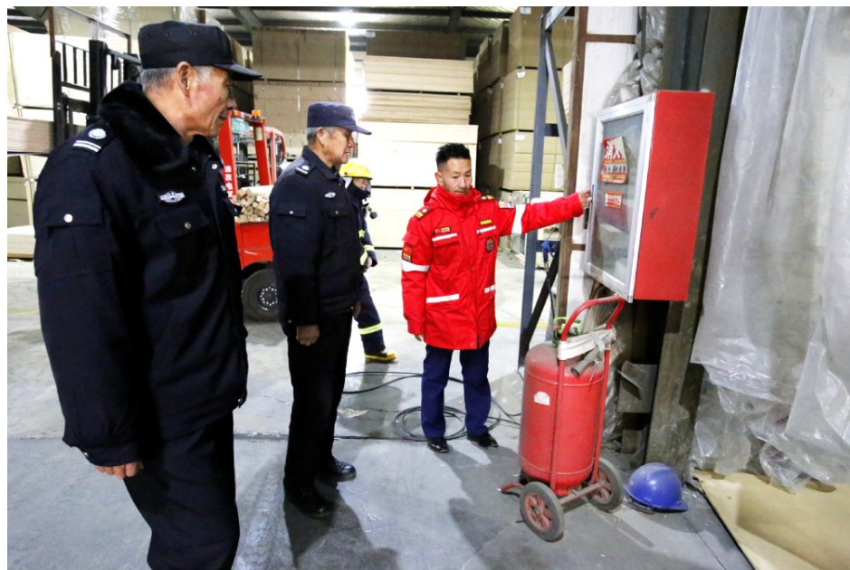
春节来临前,“小水滴”义务消防队帮助园区企业排查消防安全隐患。
