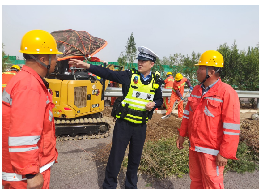
4月26日,李益峰(中)检查施工区安全防护情况,提醒工人注意观察来车。
