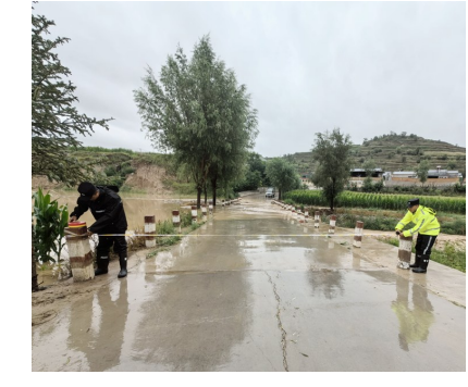
封控过水路面。
