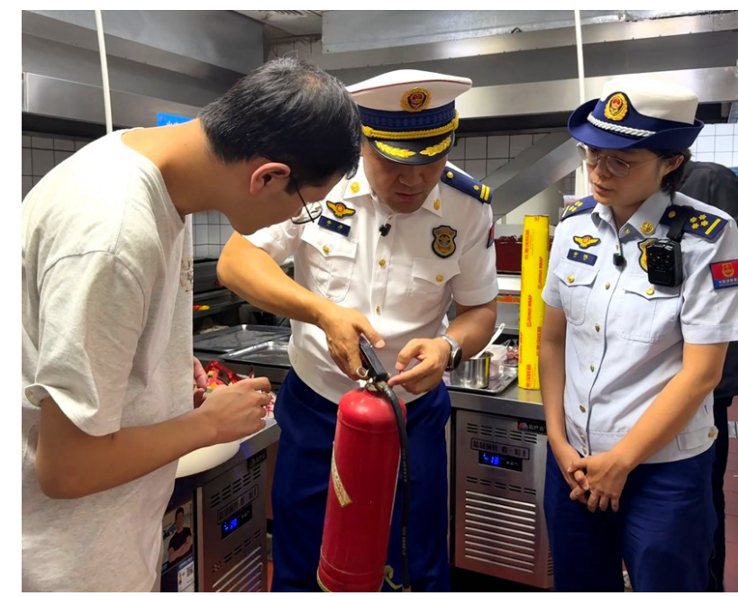
9月9日,检查人员查验一家餐厅的干粉灭火器是否完好有效。
