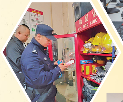
民警不定期对辖区经营场所消防、安全通道等进行检查，保障辖区安全生产。
