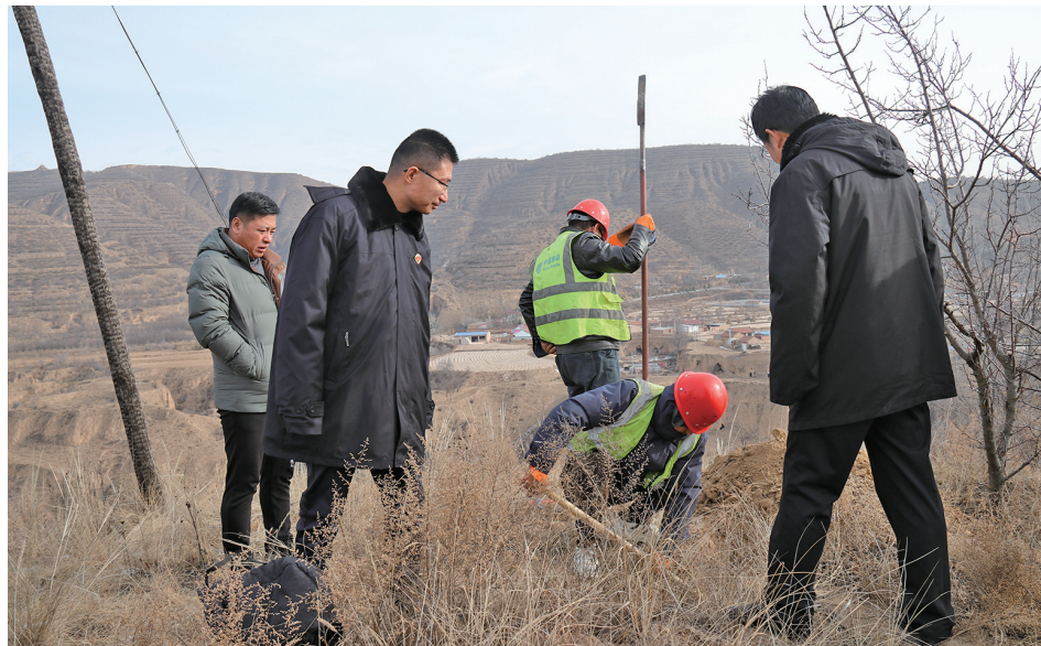
固原市原州区人民检察院检察官现场督促相关部门对长城遗址墙体上架设的电线杆进行拆除。
