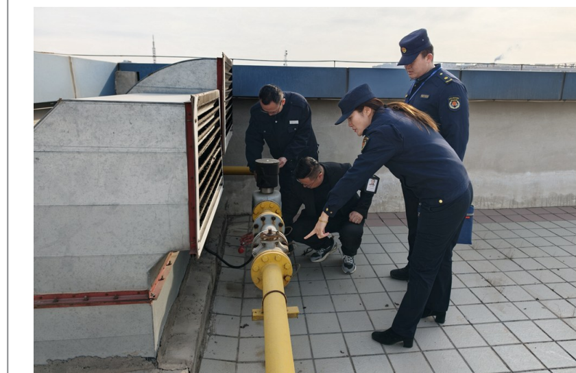
检查燃气管道。
