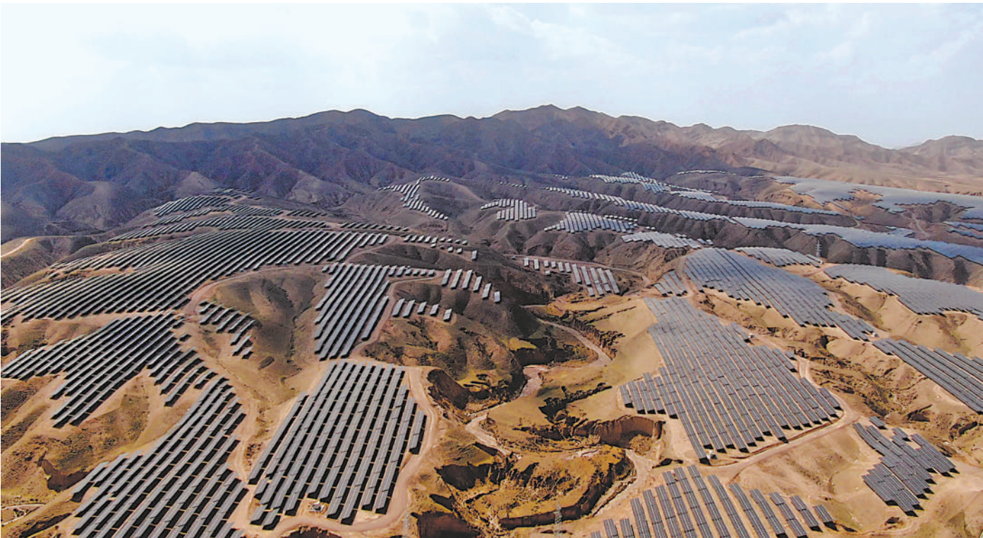
吴忠第四十五光伏电站采用3种不同容量子方阵的设计,涵盖80个发电单元。
