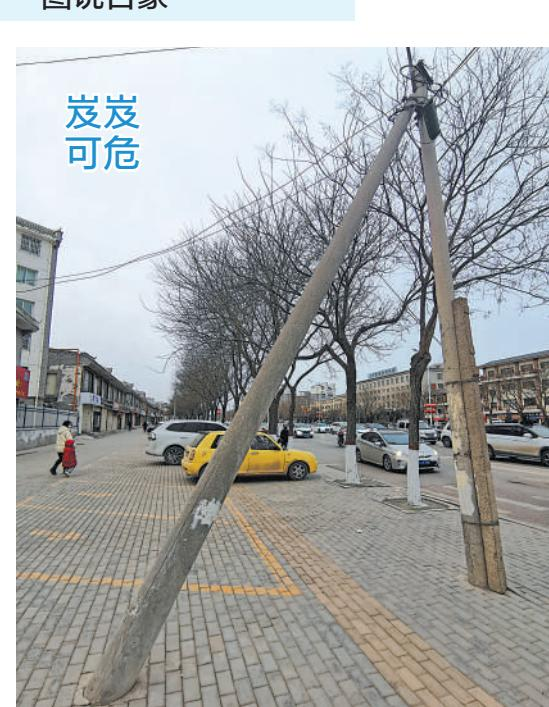
固原市原州区六盘山西路人行道上，一水泥电线杆出现裂痕后，为防止电线杆倒下，在杆体捆绑了一个水泥柱固定。不料捆绑加固的电线杆又发生倾斜，于是又用一根水泥杆将倾斜的电线杆顶住。如此“加固”，不可取！（网友 周复生 摄）
