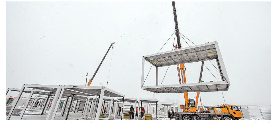
3月15日,工人在吉林省高新区隔离方舱项目施工现场吊装隔离方舱组件。新华社发
