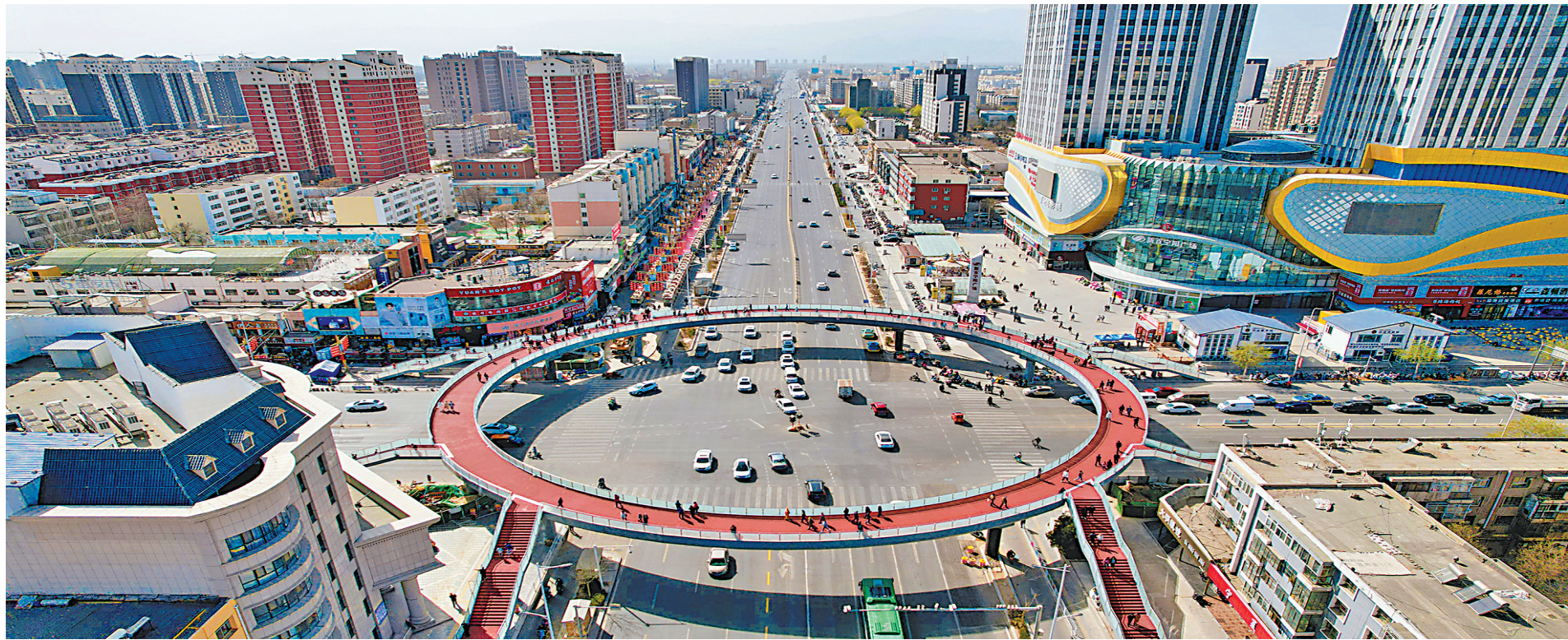
3月26日,银川市西夏区怀远路—文萃街环形过街天桥试运行。这是银川首条环形过街天桥,采用环形八跨设计,主桥长235.305米,桥面宽5.0米,桥梁底部距离地面高5.7米,每个转角都有两条步梯供行人使用。
