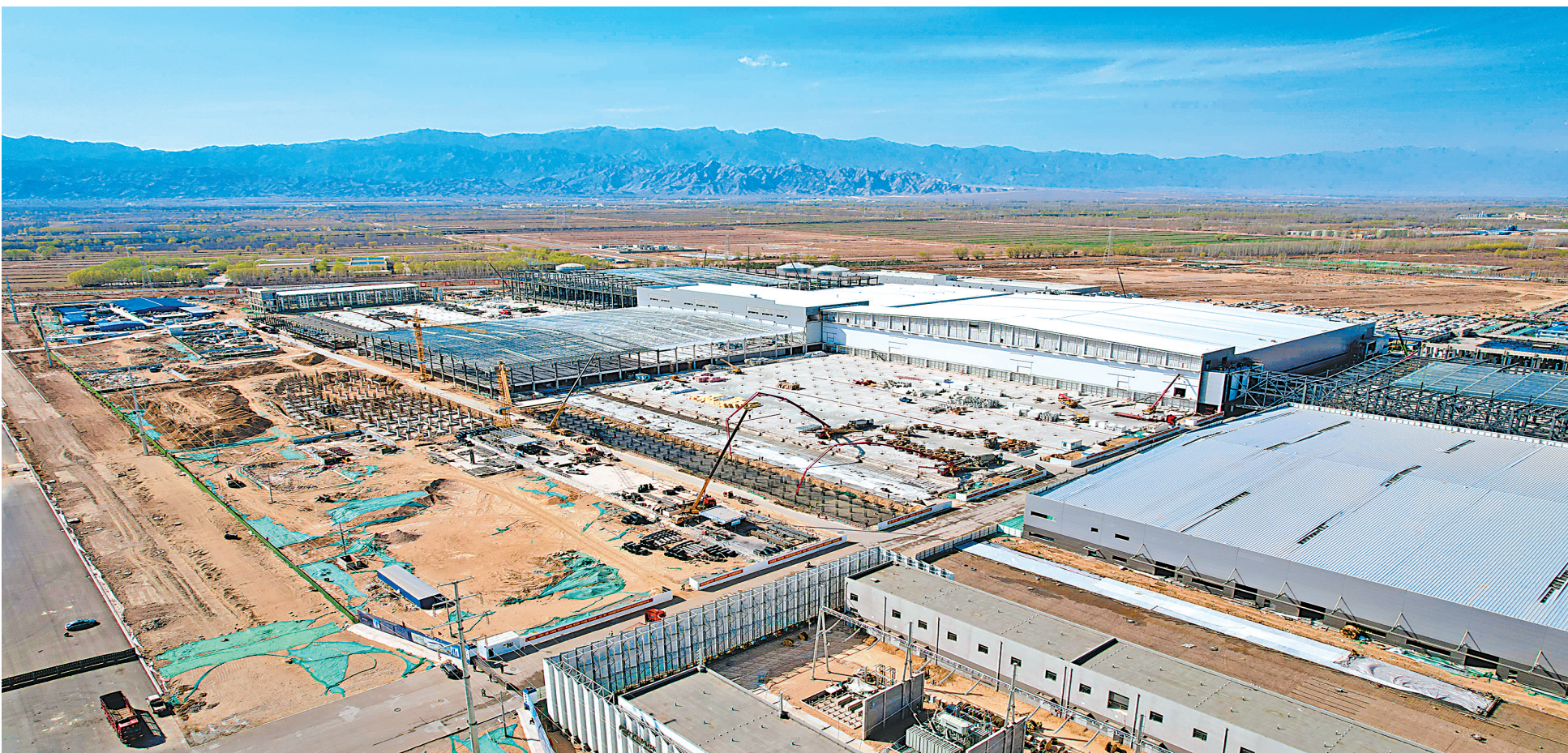
4月1日,宁夏中环光伏材料有限公司50GW(G12)太阳能单晶硅材料智慧工厂及相关配套产业项目建设现场。该项目位于银川经济技术开发区,占地800亩,总投资139.8亿元,预计年底全面建成投产。该项目全面投产后将发挥新材料行业竞争中的规模优势、成本优势,为银川经济技术开发区光伏产业全链条集群化发展、推动宁夏光伏产业实现高端化、绿色化、智能化发挥积极作用。届时可创造就业岗位4000余个,年产值200亿元以上。
