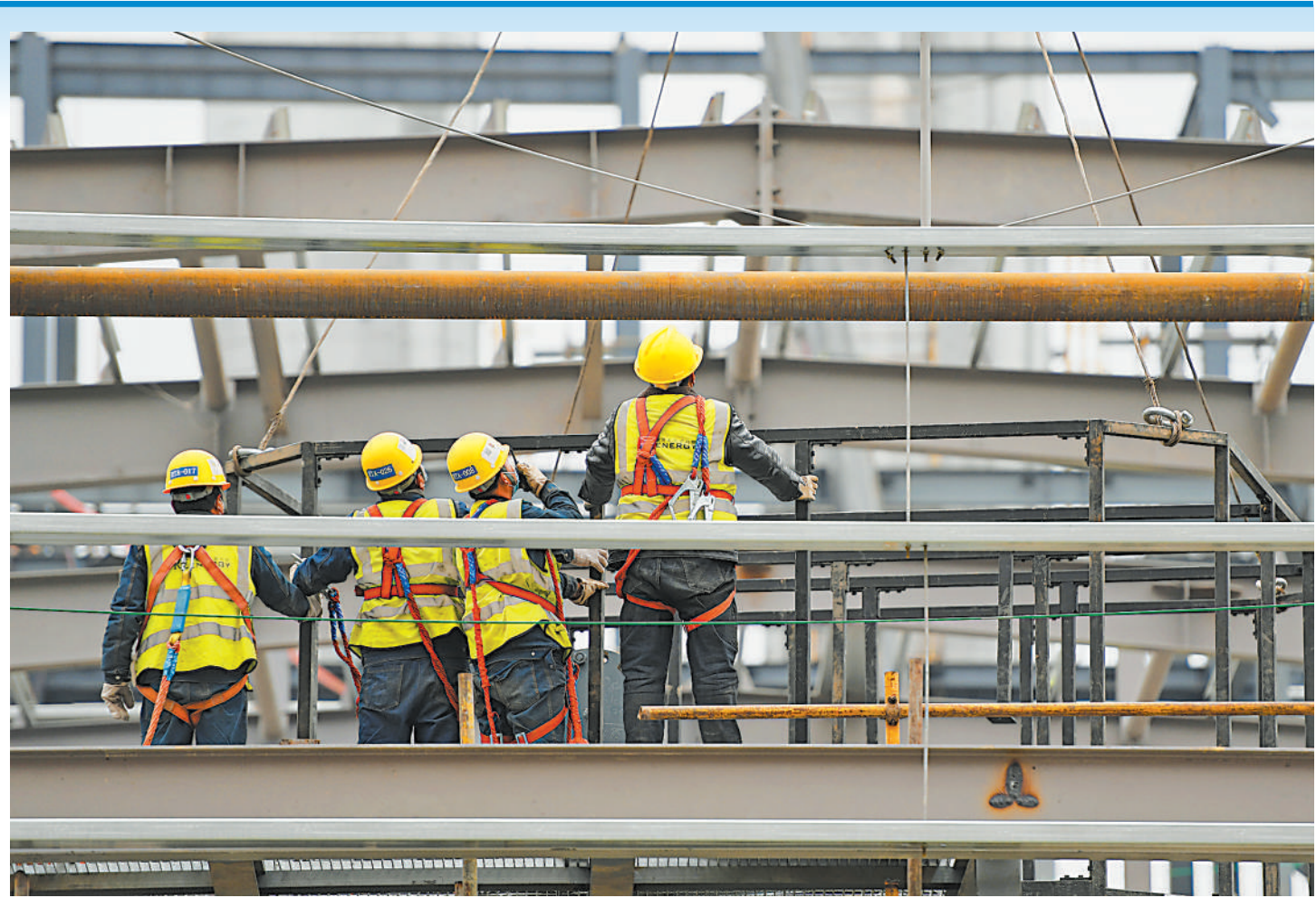
4月16日,在西安经济技术开发区南川工业园区一企业建设工地,工人在施工作业中。近日,根据青海省西宁市疫情防控政策要求,西宁经济技术开发区南川工业园区管理委员会针对园区企业集中、建设项目繁多、施工人员密集等特点,在企业建设工地设置核酸采样点,引导工人们有序开展全员核酸检测,助力企业做好疫情防控,保障项目建设。
