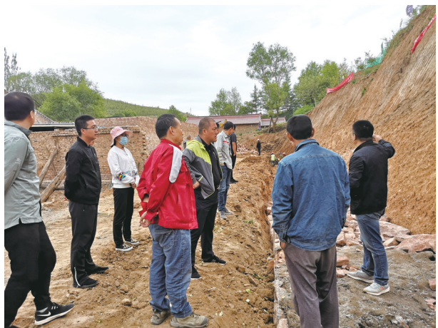
中心地质灾害工作人员检查地质灾害治理工程。
