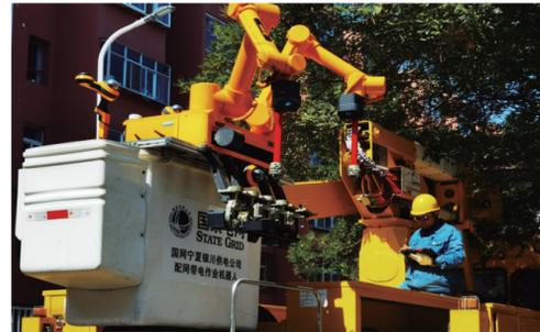
带电作业常态化后,国网宁夏电力积极探索机器人带电作业。
