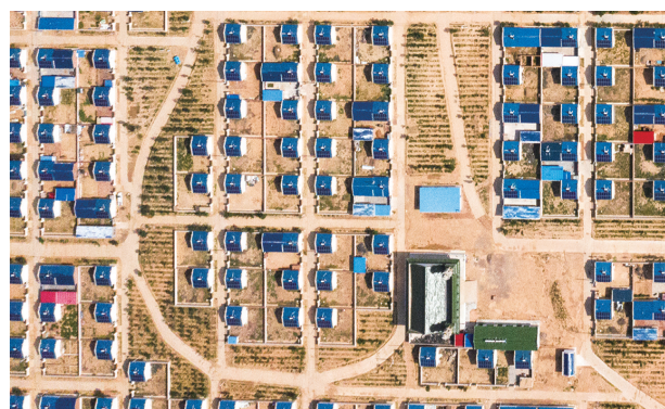
移民村旧貌换新颜。
