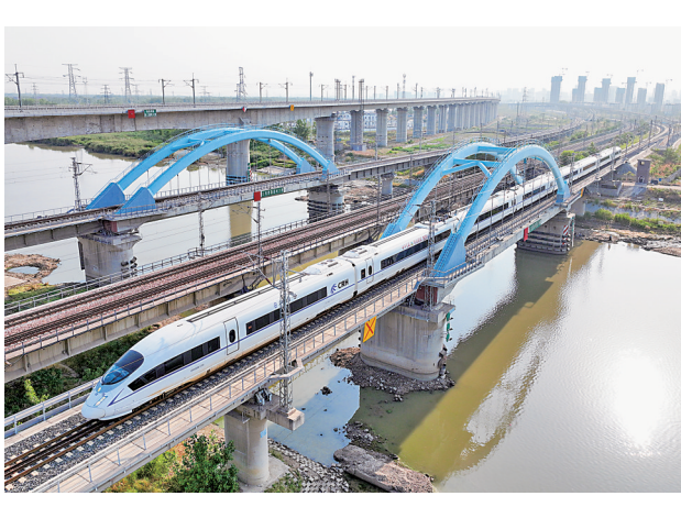
6月19日,一列动车组列车驶过江苏省连云港市海州区境内的一座铁路桥。6月20日零时起,全国铁路实行新的列车运行图,客货运输提质增效,城市间旅行时间再压缩,有效助力经济社会发展。(新华社发)
