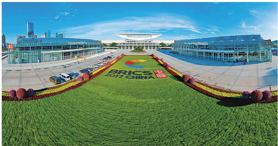
厦门国际会展中心(拼接照片)。
