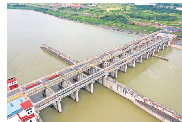
近期南方强降雨持续，广西南宁市邕宁水利枢纽工程工作人员加强对拦河大坝、电站等进行安全检修巡查，确保安全稳定。这是对位于邕江上的广西南宁市邕宁水利枢纽工程拦河大坝。(6月21日报) 新华社发
