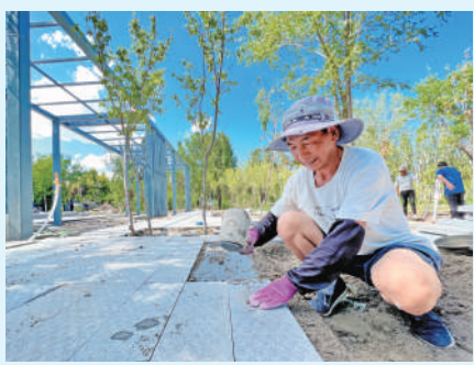
↑小微公园施工现场,工人认真铺设地砖。
