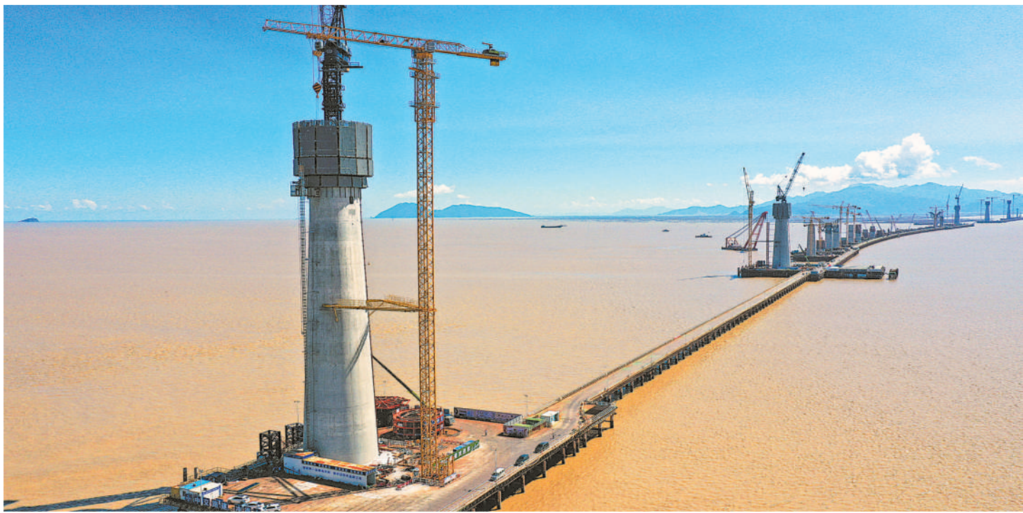
建设中的黄茅海跨海通道高栏港大桥主塔(前)(无人机照片,7月12日摄)。 目前,黄茅海跨海通道高栏港大桥建设进展顺利,大桥主塔已完成15个节段约87米高度的建设。高栏港大桥东连从港珠澳大桥连接线引出的鹤港高速,西接黄茅海大桥,是黄茅海跨海通道的组成部分。 黄茅海跨海通道横跨珠江口崖门入海口黄茅海水域,线路全长约31公里,预计2024年建成通车。 新华社发
