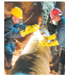
深夜抢修保供水。
