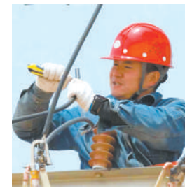
紧急抢修供电线路全力保障供水。
