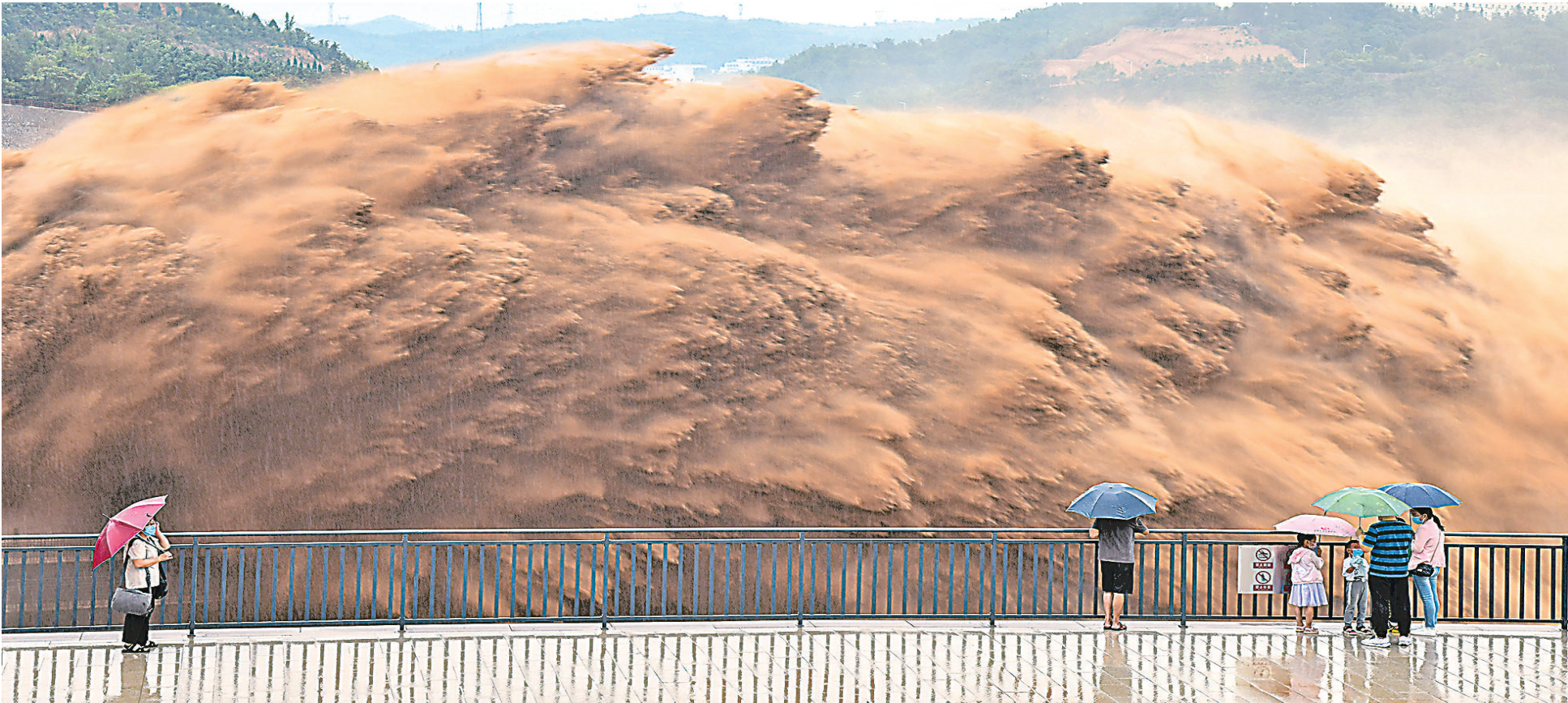
7月19日,游客观看黄河小浪底水库大流量泄洪。7月10日以来,黄河上中游地区发生了强降雨过程。为保障黄河下游防洪安全,黄河小浪底水库于7月17日开始防洪运作,提前降低库水位,留足防洪库容。 新华社发
