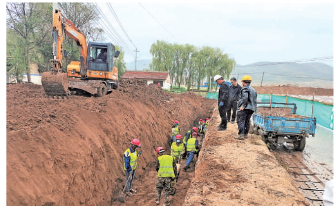
固原市原州区官厅镇官厅村村民参与工程项目建设。
