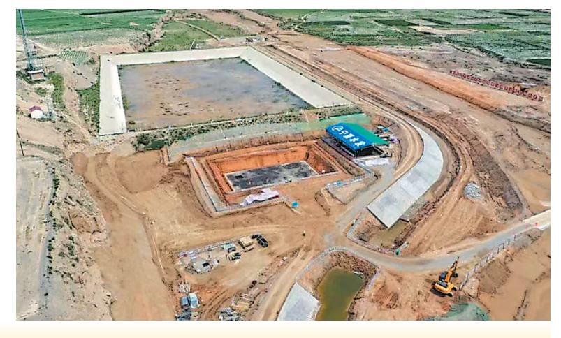
7月25日,中部干旱帶海原县西安供水水源工程正在加紧建设中。项目总投资6.97亿元,主要以固海扬水七干渠为水源,通过建设4级扬水泵站、铺设70.94公里供水管道,将黄河水扬至590余米,并输送至海原县两安灌区,为海原县关桥、西安、海城3个乡镇12万亩高效节水灌溉农田提供水源。预计2024年4月正式投入运行。
