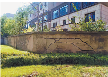
分隔国奥村小区和万科翡翠公园小区的这堵水泥墙墙体有多处裂缝。
