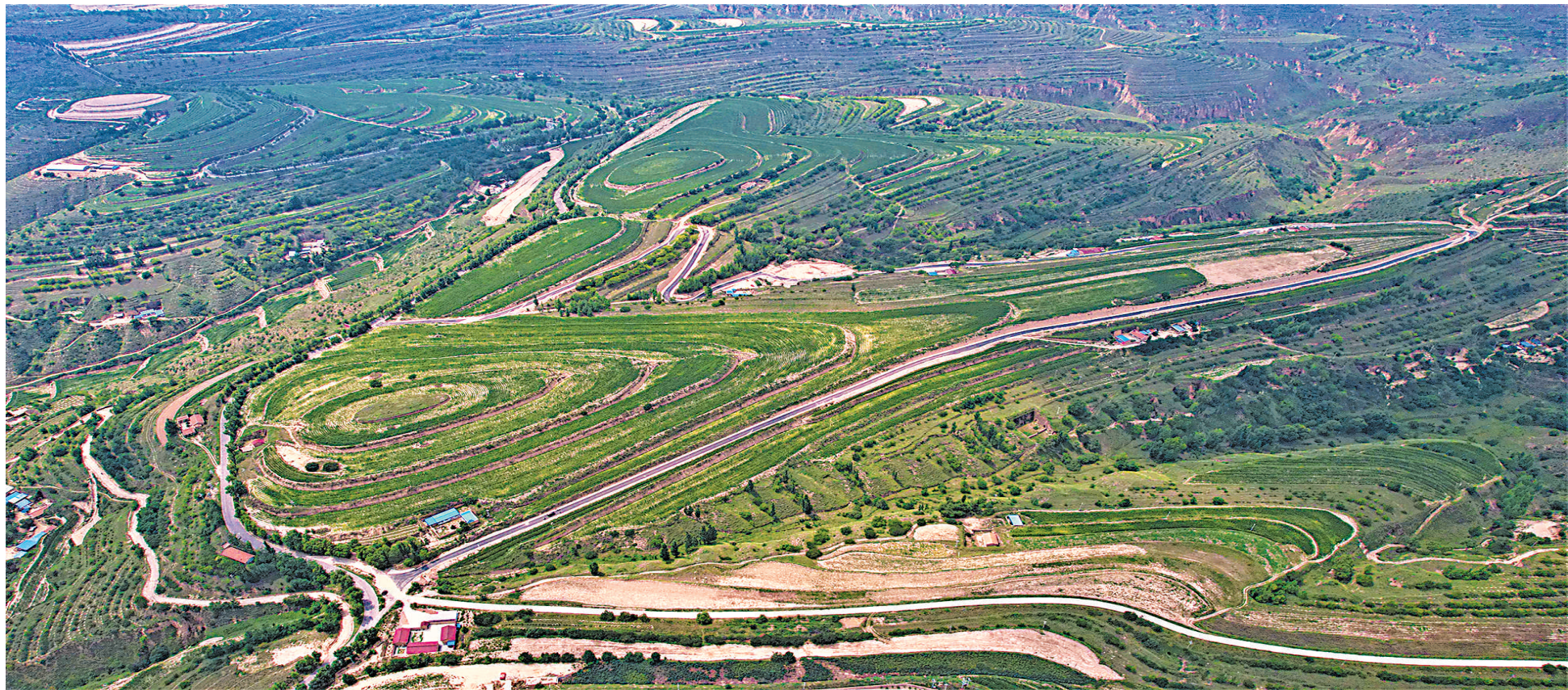
彭阳县小岔乡小南沟公路是宁夏首条“黄土固化”道路。
