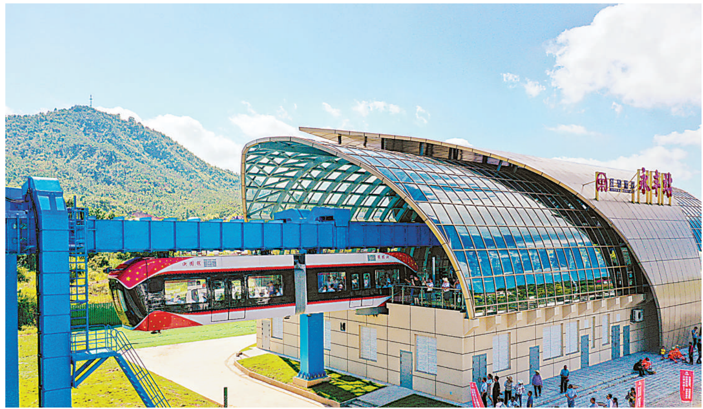
8月9日,“红轨”试验线列车驶出车站。当日,国内首条稀土永磁悬浮轨道交通工程试验线——“红轨”,在江西兴国县正式竣工,并实现将稀土永磁悬浮技术与空轨技术结合,建成中低速、中低运量的新制式轨道交通系统。“红轨”试验线由江西理工大学牵头,与江西兴国县人民政府联合中铁六院、中铁工业、国家稀土功能材料创新中心等单位共同完成。正线全长约800米,均为钢构高架梁,磁浮列车采用2车编组,载客能力为座席32个、定员88人,最高设计运行速度为80公里每小时。
