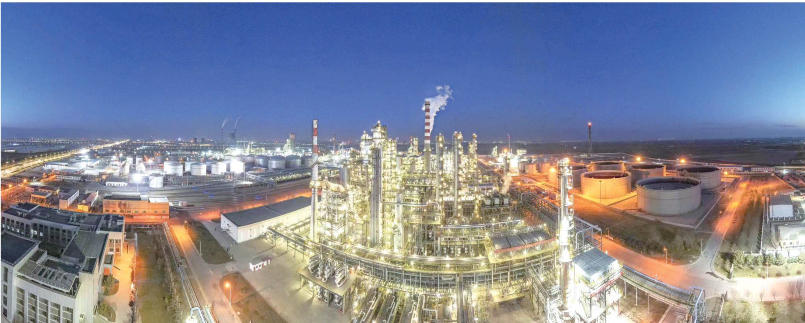
中国石油宁夏石化公司生产装置区夜景。
