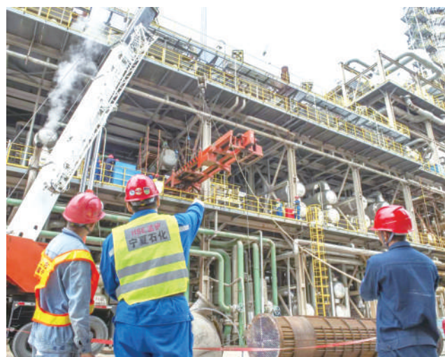
8月5日，常压蒸馏装置吊装作业现场管理规范，安全监护人员全程监护，检修作业安全有序进行。当前，公司深入贯彻安全发展理念，持续深入查隐患、补短板、夯基础，常态化开展安全隐患排查整治等活动，大力推进安全管理提升，全力保障安全生产。
