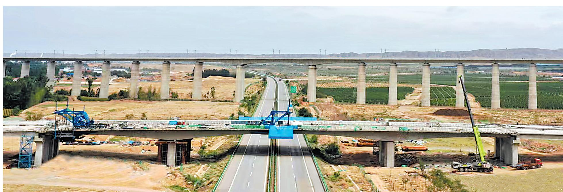
8月24日,自治区重点项目——中卫下河沿黄河公路大桥上跨定武高速桥右幅挂篮施工合龙。中卫下河沿黄河公路大桥是宁夏规划建设的第20座黄河公路大桥,全长1228米,主桥宽36.6米,为双向6车道。上跨定武高速桥全长390米,单幅净宽11.9米,双向4车道。
