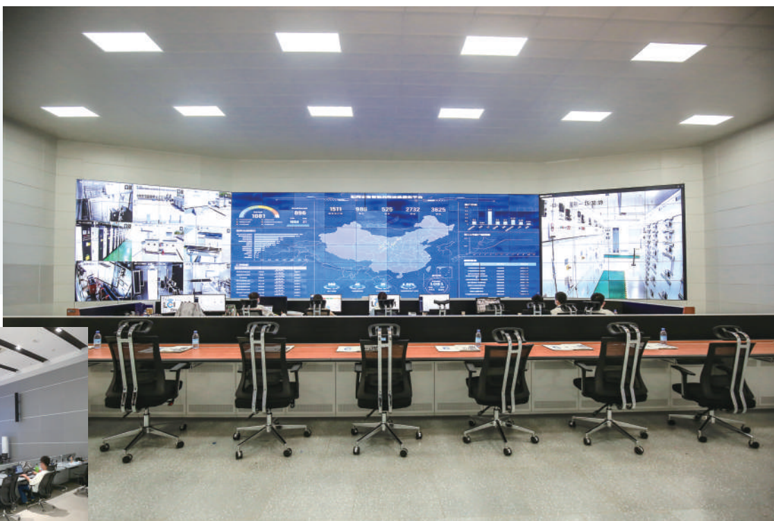
力成电气远程数字运维中心。
