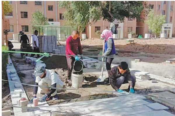
吴忠市利通区芸香苑小区使用住宅专项维修资金整修路面。
