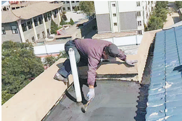
吴忠市利通区滨河锦都小区使用住宅专项维修资金维修屋顶。
