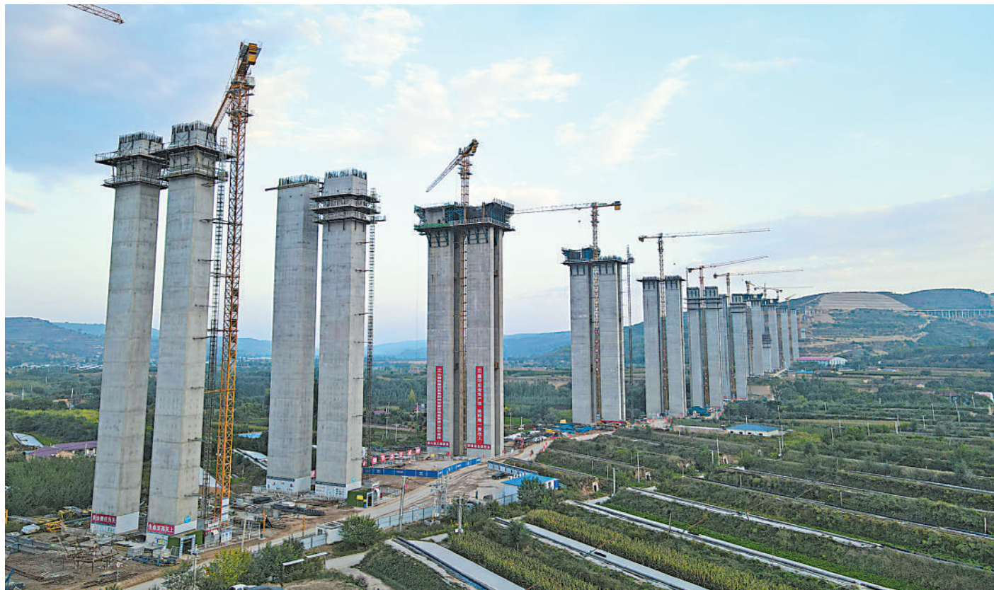
友联红河特大桥全长2161米,是银昆高速公路太阳山至彭阳段墩身最高、跨度最大的桥梁。18个主墩中最高处109米、最大跨度140米。 本报通讯员 张双宝 张文斌 摄
