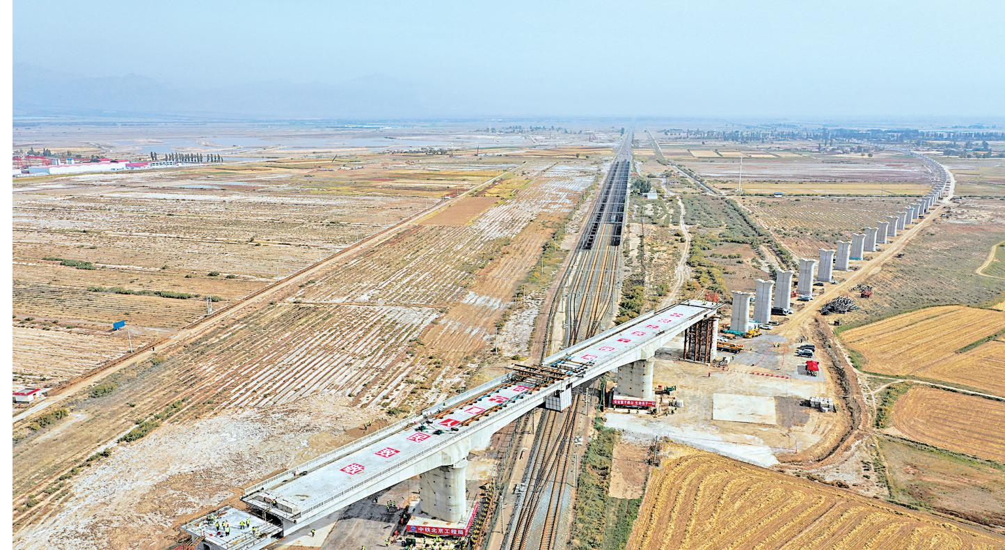
包银铁路银川至惠农段石嘴山特大桥上跨包兰铁路(48+80+48)m转体桥施工现场,经过忙碌而有序的施工,转体顺利完成。本报记者 王婧雅 摄
