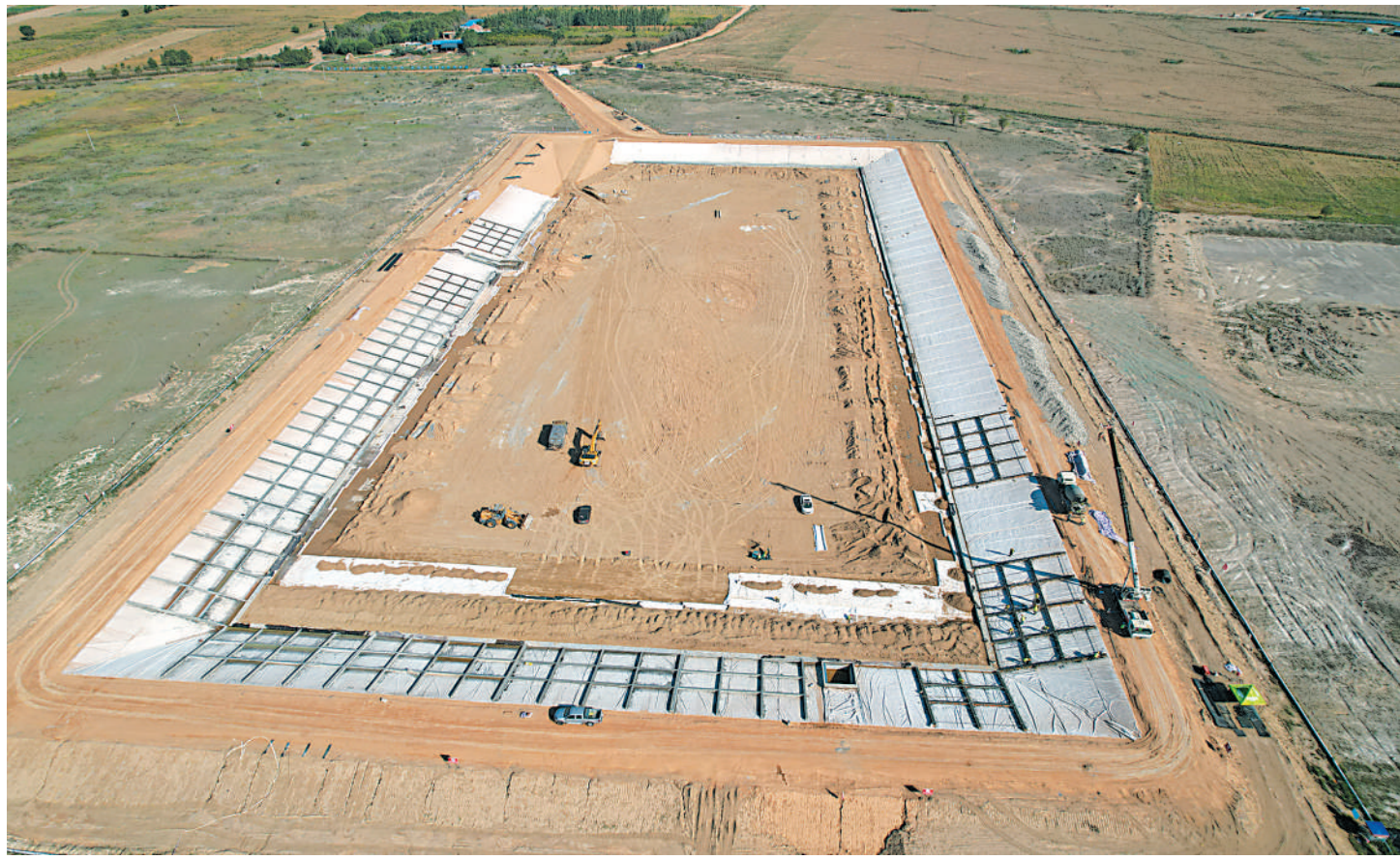
银川都市圈中线供水工程建设现场。图为位于平罗县高仁乡东沙村的中线供水工程5#蓄水池。(图片由受访单位提供)
