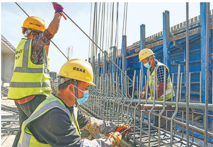
10月4日,中铁二十局六公司工人在银昆高速公路9-1标段预制梁场绑扎T梁钢筋。
