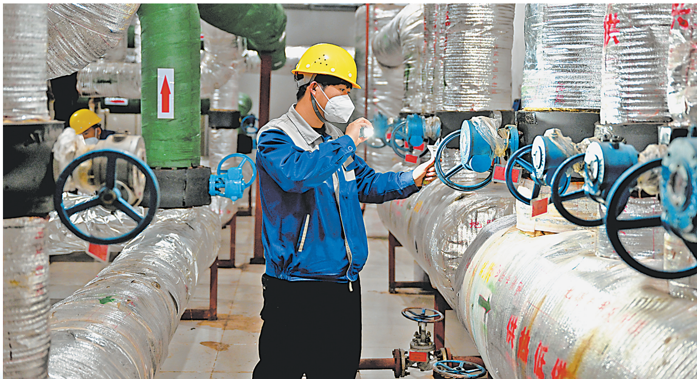
10月11日,阅海万家G2区换热站,宁夏百新能源科技发展有限公司维保人员杨绍超巡检供暖设备重点部位。
