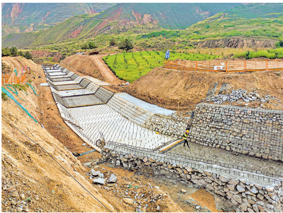
溢洪道加固改造工程施工现场。
