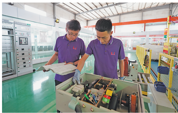
宁夏凯晨电气集团员工在安装智能化配电设备。
