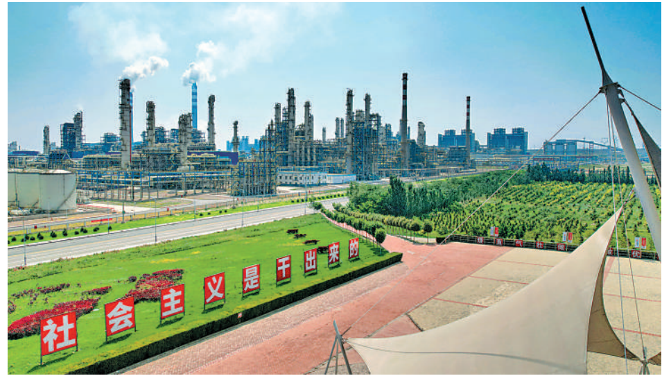
2022年8月5日,从高处远眺,神华宁煤400万吨/年煤炭间接液化示范项目,犹如钢铁巨人巍然屹立,“社会主义是干出来的”大型标语格外醒目。本报记者 王猛 王晓龙 摄
