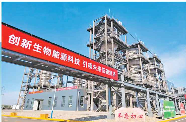
宁夏首朗吉元新能源科技有限公司全球首套4.5万吨/年冶金工业尾气生物发酵制燃料乙醇项目,以铁合金矿热炉尾气为原料,通过生物发酵技术将之转化为燃料乙醇、蛋白饲料等。 本报记者 丁建峰 摄
