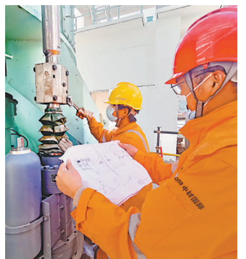
宁夏青铜峡水泥股份有限公司机械设备安装人员在调试煤磨液压杆。
