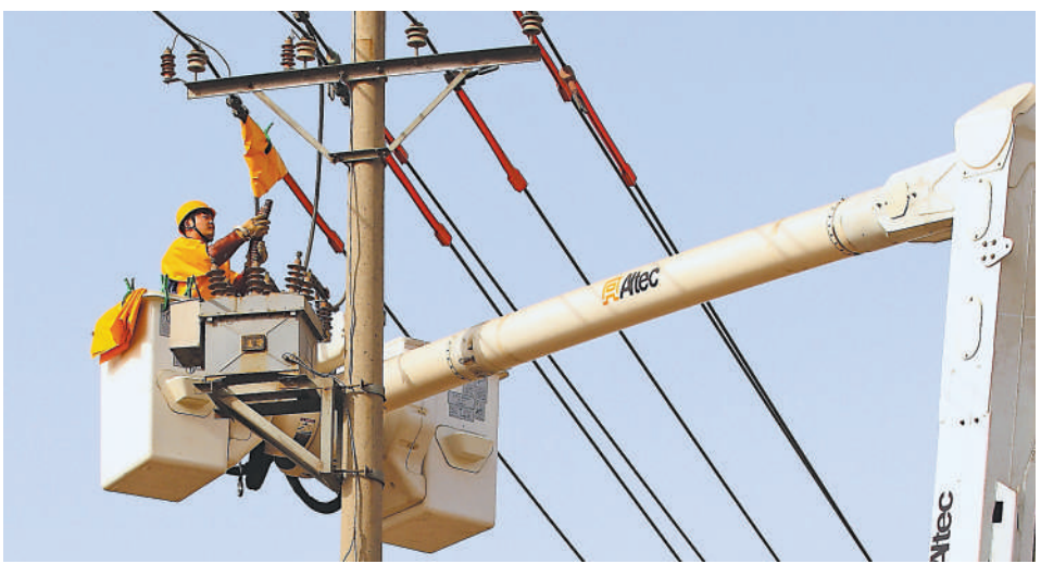
2013年2月26日,国网银川供电公司员工开展带电拆除引流线工作。
