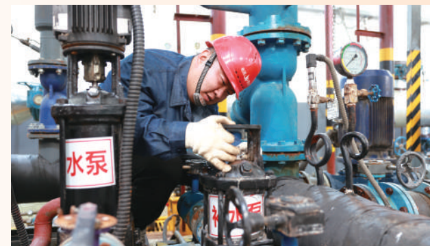
设备检修维护。
