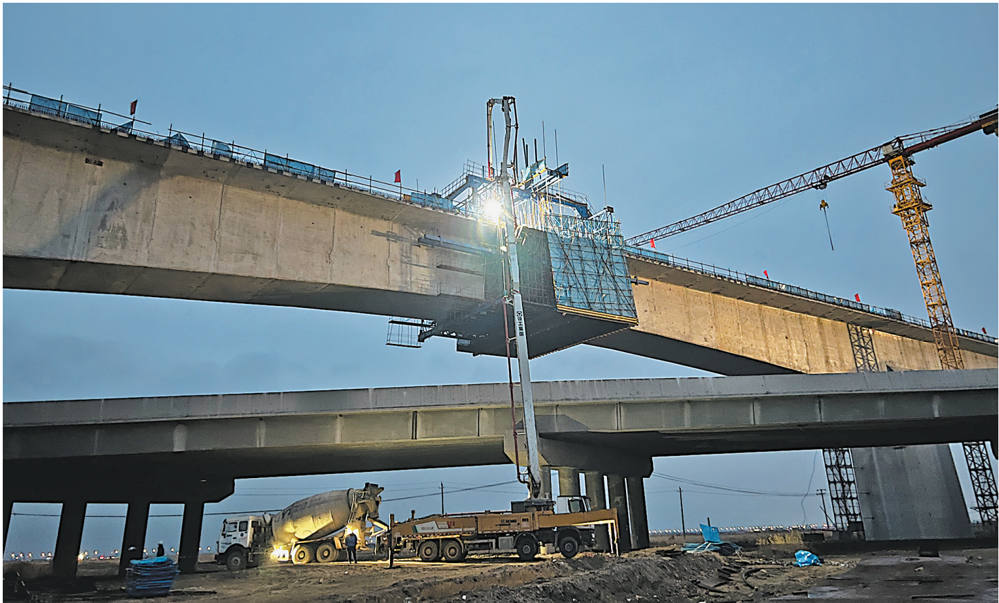
120米连续梁成功合龙。 （图片由中铁北京工程局包银铁路惠银项目提供） 10月28日22时许，经过4个小时的紧张作业，跨简滨公路（60+120+60）米的连续梁终于成功合龙。该项目负责人介绍，在“决胜四季度”劳动竞赛活动的冲刺阶段，全线最大跨度连续梁合龙段顺利完成浇筑，不仅完成了上级单位下达的特殊节点施工任务，得到
