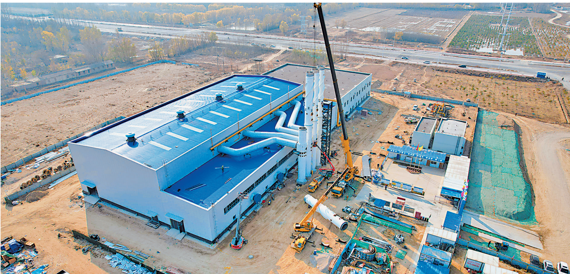
11月6日,宁夏电投清洁能源智慧供热项目一期工程建设现场,工人们在大型工程机械的帮助下安装设备,预计12月试运行。项目建成后,热源厂燃气热水锅炉供热能力将达到490MW,满足900万平方米供热面积,分布式清洁能源供热能力达到50MW,满足100万平方米供热面积。
