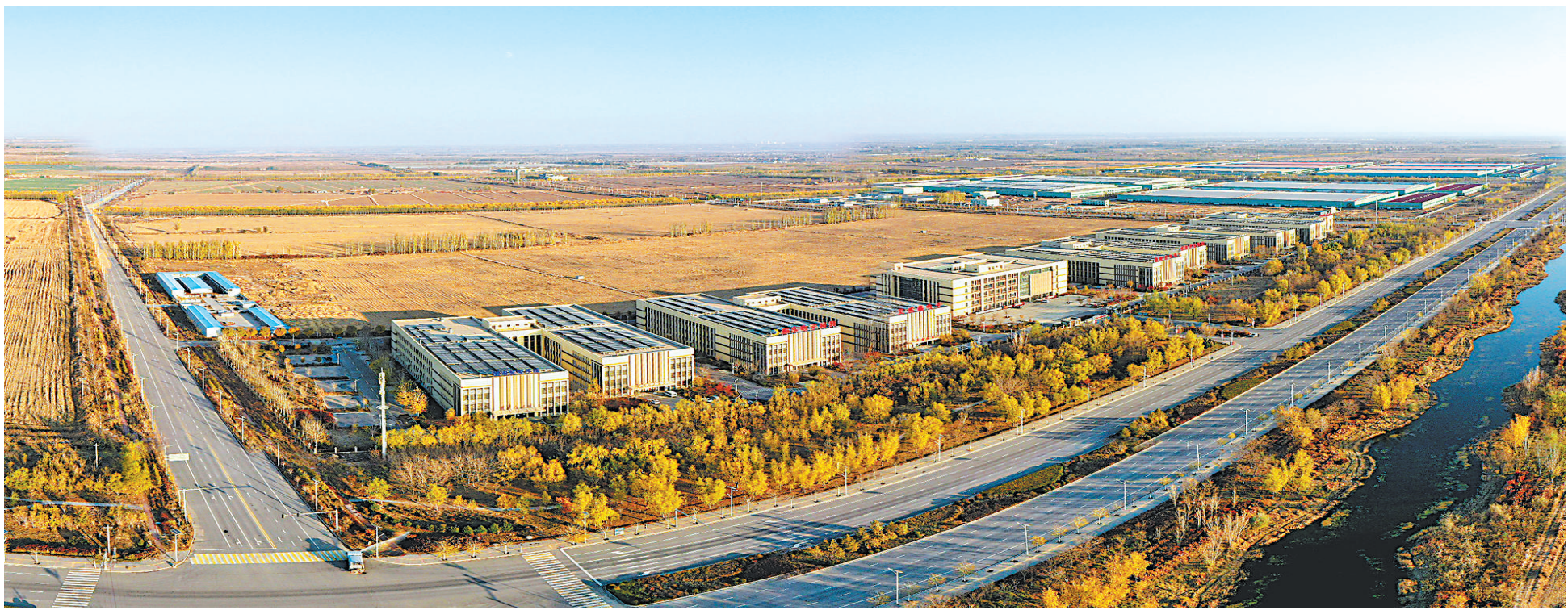
日前,在贺兰工业园金贵片区,企业办公楼和生产车间顶部均安装了太阳能光伏设施,为企业提供清洁能源。贺兰工业园实施新能源分布式试点县项目,建设一批光伏建筑一体化设施,推动清洁能源规模化发展,并加快智能终端数据中心全产业链发展,打造清洁能源和电子信息综合示范园区。
