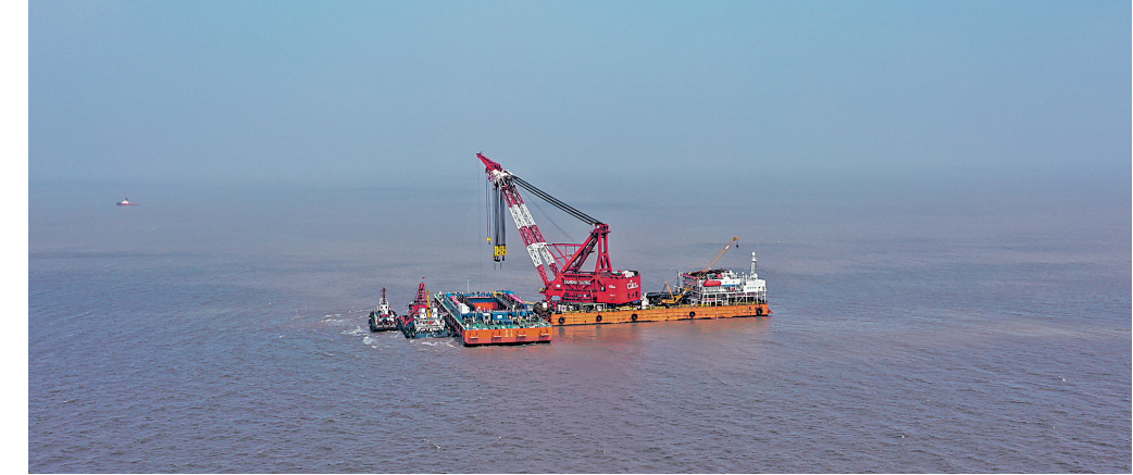
11月20日拍摄的长江口二号古船整体打捞现场(无人机照片)。
