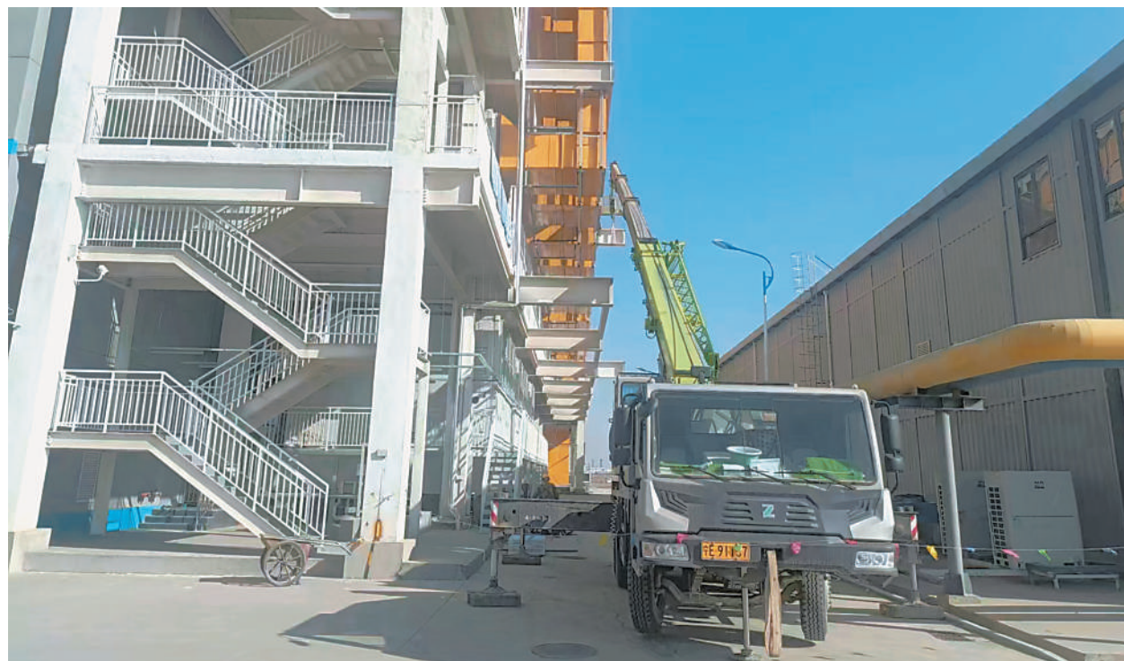
项目现场,加班加点赶工期。
