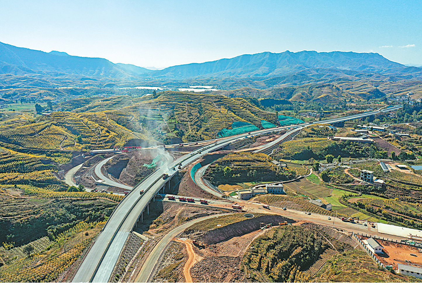
这是11月25日拍摄的四川沿江高速会东南—会理南阁互通先期通车段施工现场。当下,四川沿江高速南至攀枝花段在紧张施工中,其中全长30余公里的会东南—会理南阁互通先期通车段路基、桥梁、隧道工程均已完工,预计12月建成通车。届时,凉山彝族自治州境内会东县和会理市将结束不通高速的历史,车程将由原来的1小时20分钟缩短为20分钟。 新华社发
